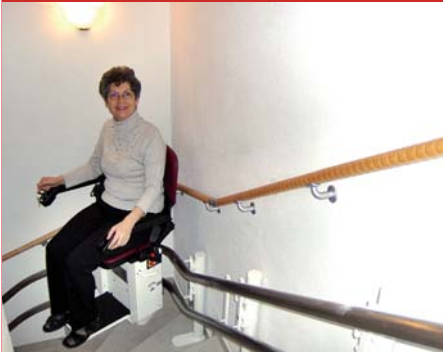
Der Holzhandlauf in Ergänzung zum Treppenlift
