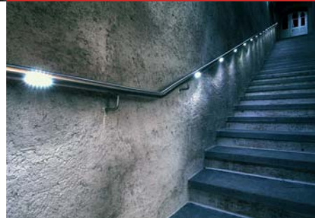
Handlauf mit integrierter LED-Beleuchtung
