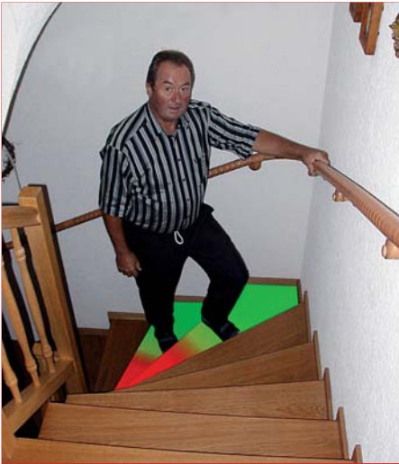
Sicheres Gehen. Rot markiert die gefährliche schmale Trittfäche, grün die sicherere Seite, auf der sich der Außenhandlauf befindet.
