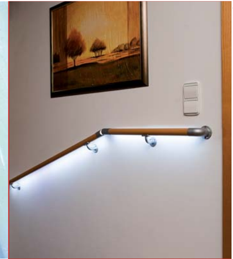
Indirekte Ausleuchtung der Treppe mit LED-Technologie
